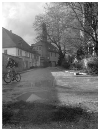
An der Kirche St.Peter und Paul in Oberweimar führt der Ilmtalradweg vorbei – hier besteht dringender Handlungsbedarf
